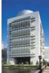
大阪国際会議場 (グランキューブ大阪)
